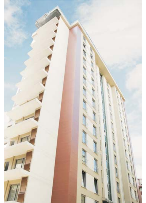
Kozal Residence - İnanlar İnşaat, İstanbul
